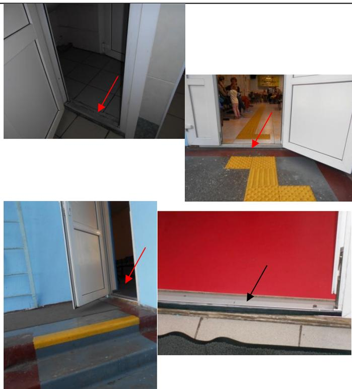
Выполнить по осям 2-5/А-Б с отм.+0,00м до отм.+5,81м, согласно п.5.2.9 СП 5913330.2012 по боковым краям ступеней бортики высотой не менее 0,02м или другие устройства для предотвращения соскальзывания трости или ноги.
