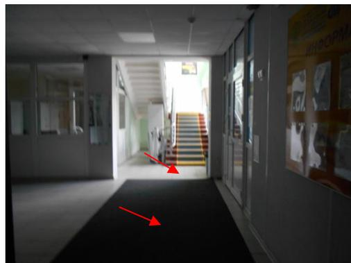
Следует оборудовать объект планами эвакуации, выполненными в фотолюминесцентном исполнении, а также на полу и стенах коридоров (в том числе на высоте не более 0,4 м от уровня пола) установить сигнальную разметку в фотолюминесцентном исполнении, выполненную в соответствии с требованиями ГОСТ Р 12.4.026-2001 «Цвета сигнальные, знаки безопасности и разметка сигнальная».
